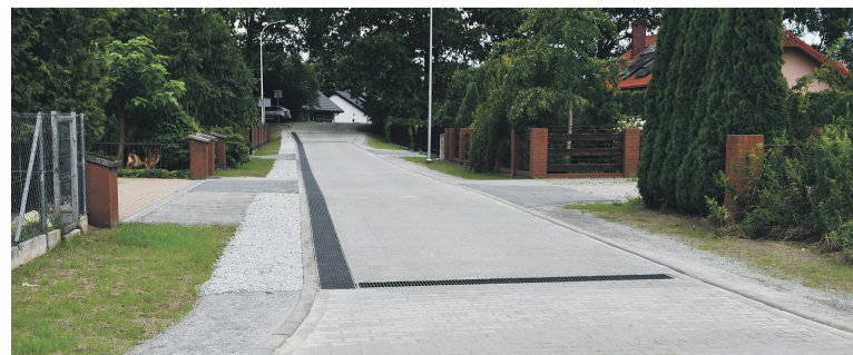
Ligota Mała - droga przed i po przebudowie
