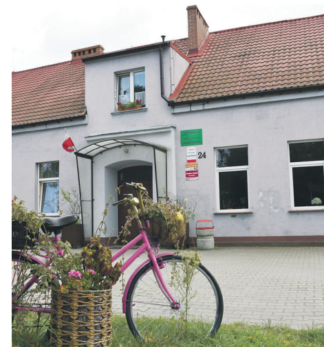
Budynek świetlicy przed termomodernizacją
