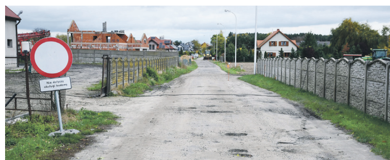
Droga w Nieciszowie przed przebudową
