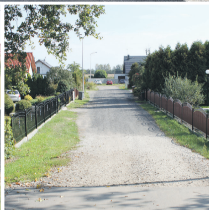
Droga w Ligocie Małej przed przebudową
