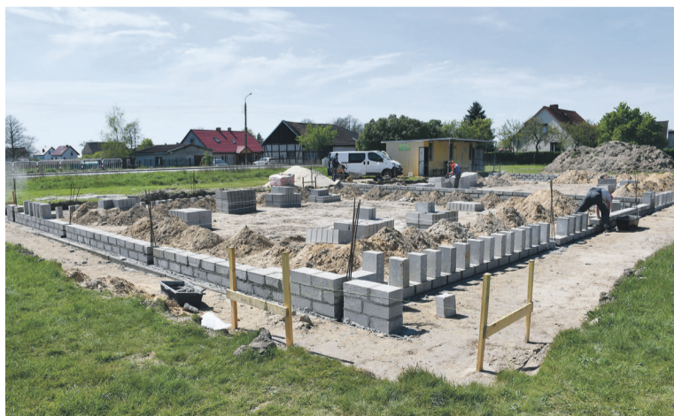
Początek prac w Boguszycach
