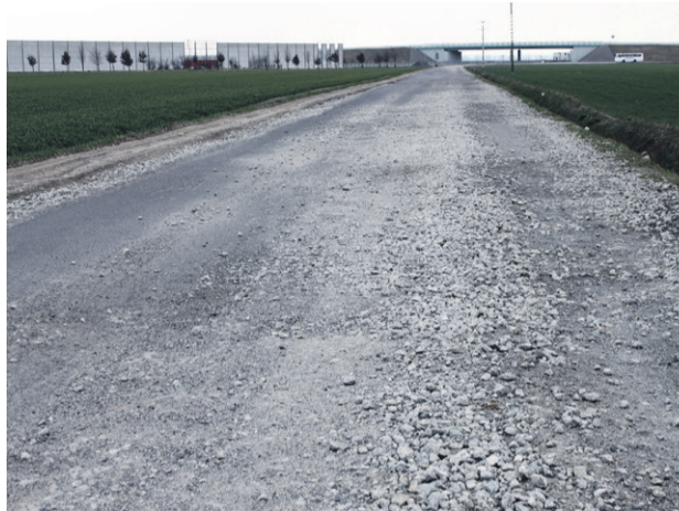
Droga w Dąbrowie przed remontem
