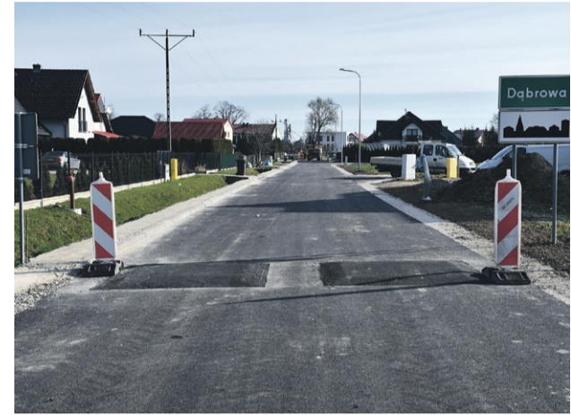
Droga w Dąbrowie w przeddzień odbioru
