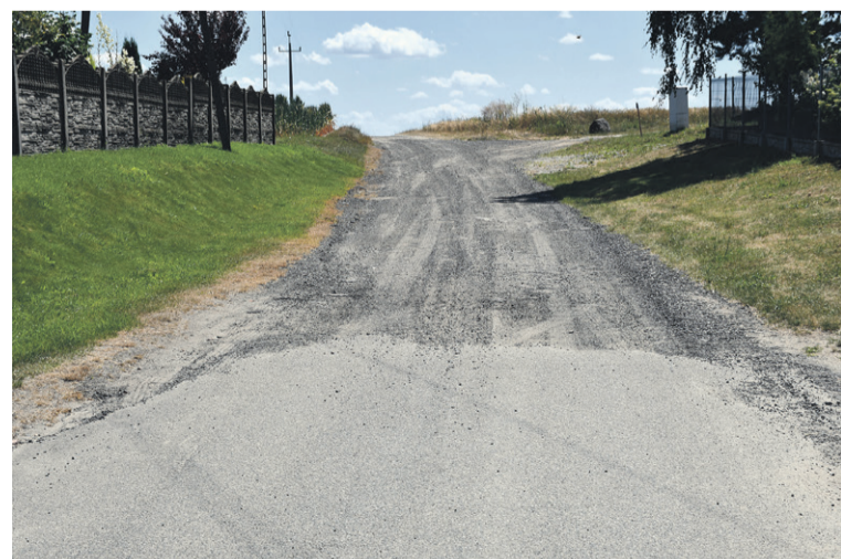
Poniatowice - droga do przebudowy
