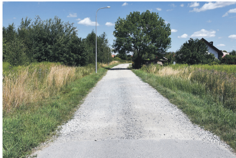
Cieśle - droga do przebudowy
