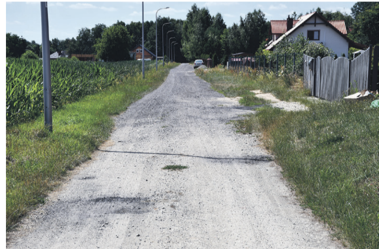
Piszkwawa - droga do remontu
