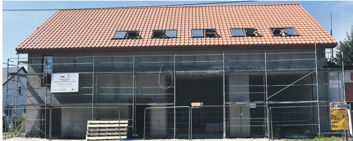
Budowa remizy w Ligocie Małej jest już za półmetkiem. Powinna być gotowa już w listopadzie
