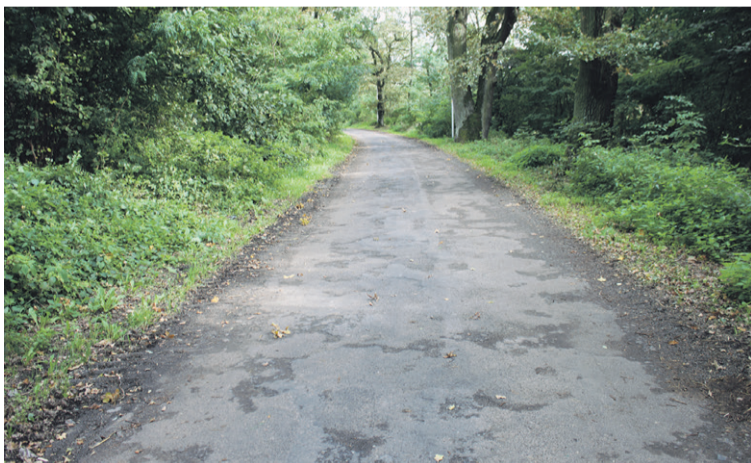
Tak droga w Ligocie Polskiej wyglądała przed przebudową...
