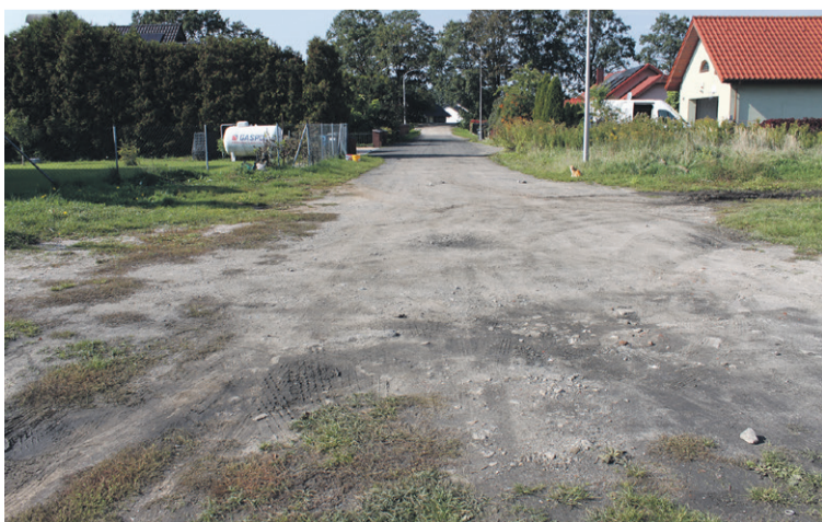
W Ligocie Małej przebudowano zniszczoną drogę wewnętrzną
