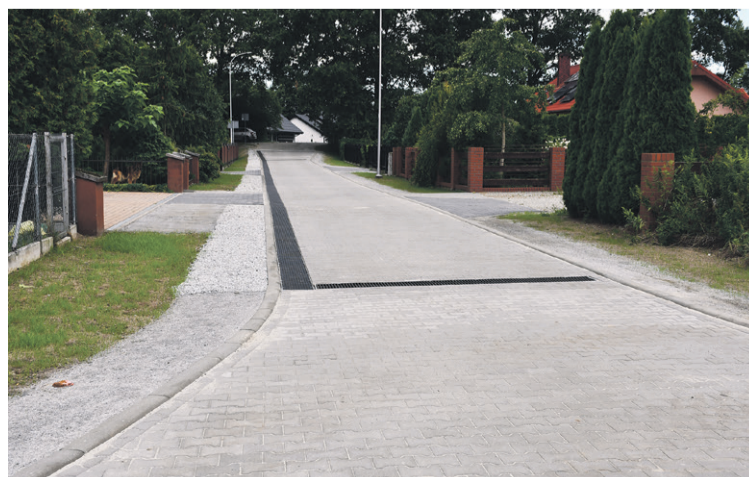
Wykonano jezdnię z obustronnymi pobocznymi
