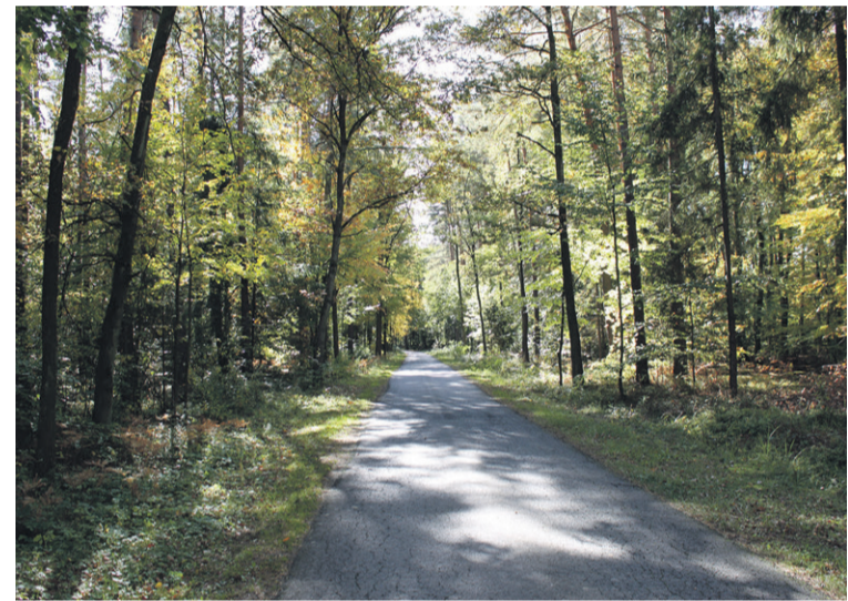
Zdegradowana droga w Osadzie Leśnej będzie jak nowa
