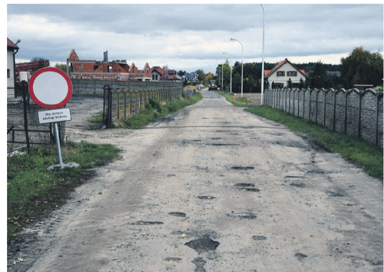
W Nieciszowie prace już się rozpoczęły
