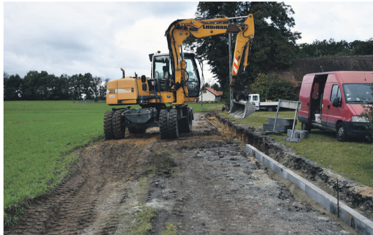
Trwają prace na Ostrowinie, wraz z budową kanalizacji deszczowej
