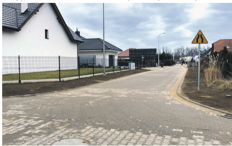
Ulica Bukowa w Spalicach po przebudowie
